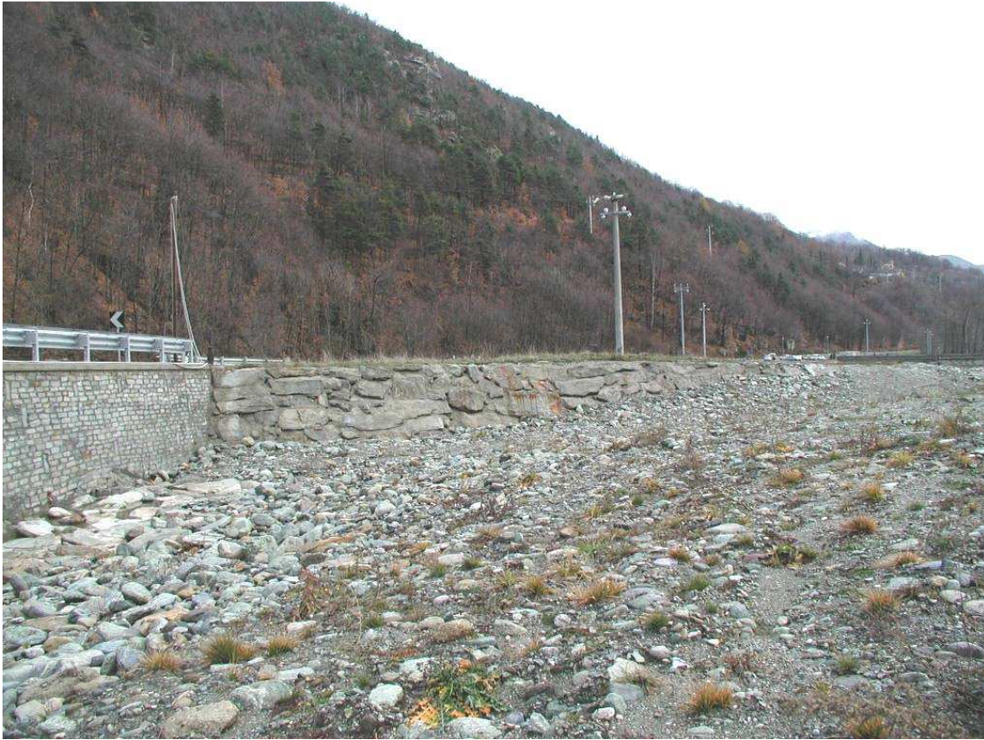
Foto 033 – Opera BATTDS037 . Ripresa da monte, sponda sinistra del T. Chisone.
