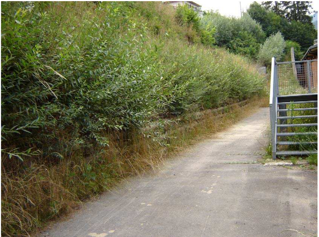
Foto 002 – Opera BATTOSS002 – Ripresa da valle dell'opera (a monte dell'edificio scolastico).
