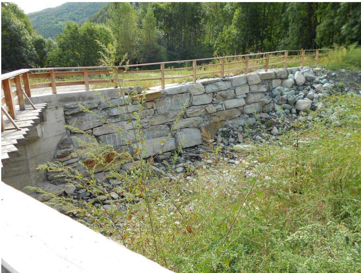
Foto 035 – Opera PAIRDS039 . Da valle, in corrispondenza dell'alveo del T. Garnier.
