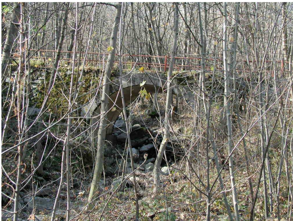
Foto 003 – Opera BELTPO003 . Da valle, sponda sinistra del rio affluente del T. Chisone.
