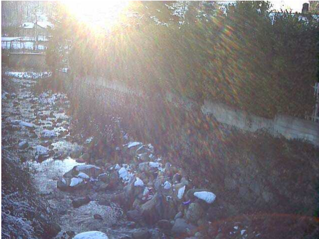
Foto 023 – Opera BELTDS026 . Ripresa da monte del muro di sponda destra del Rio Comba Ciampiano.
