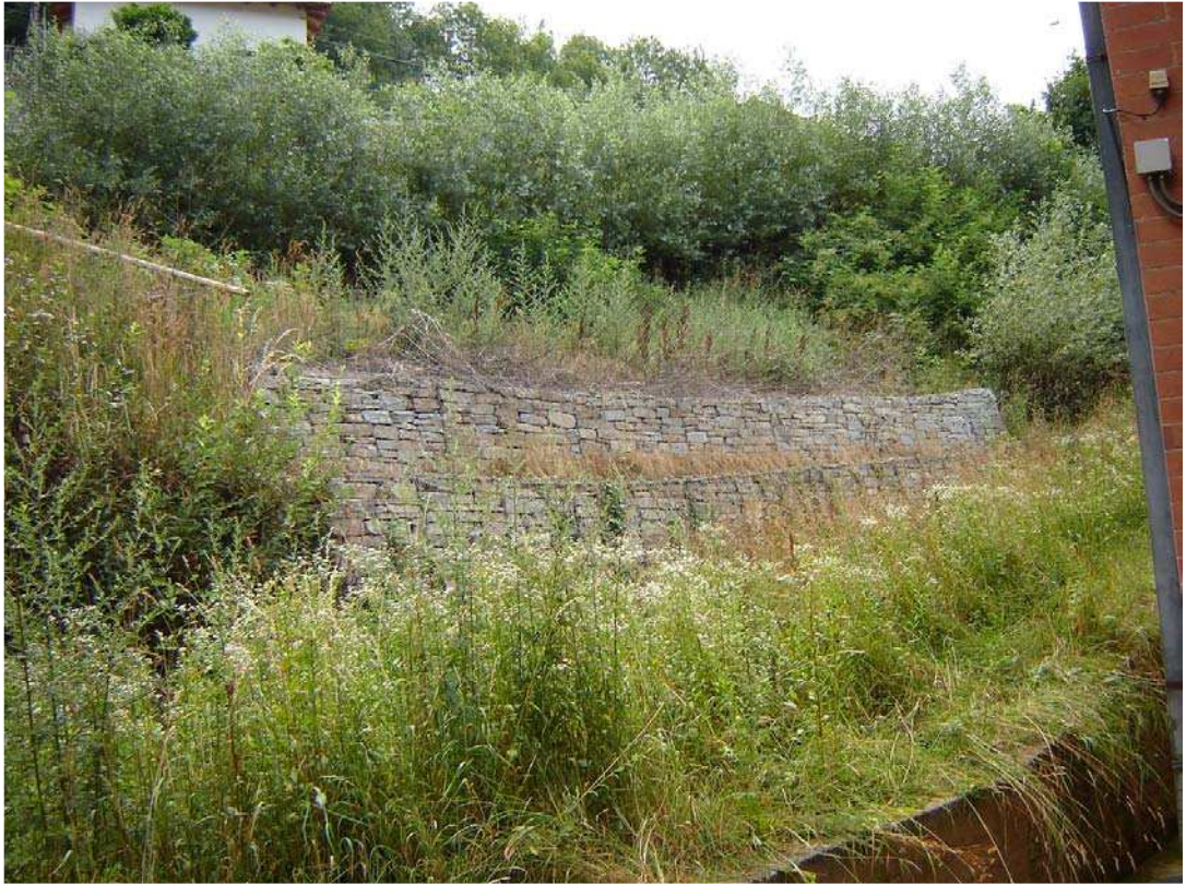
Foto 003 – Opera BATTOSS003 – Ripresa da valle dell'opera (a monte dell'edificio scolastico).
