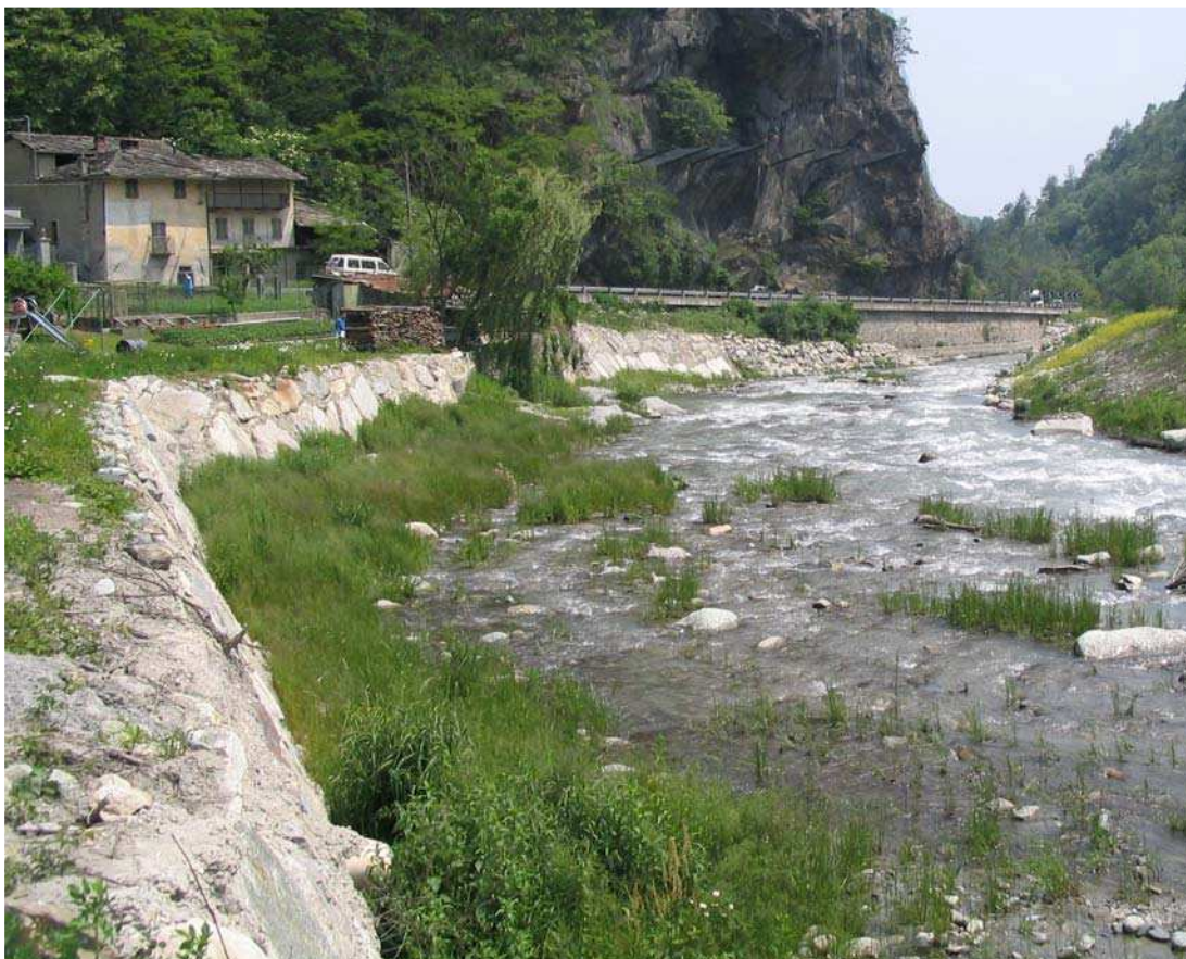
Foto 031 – Opera BATTDS035 . Ripresa da monte, sponda sinistra del T. Chisone.
