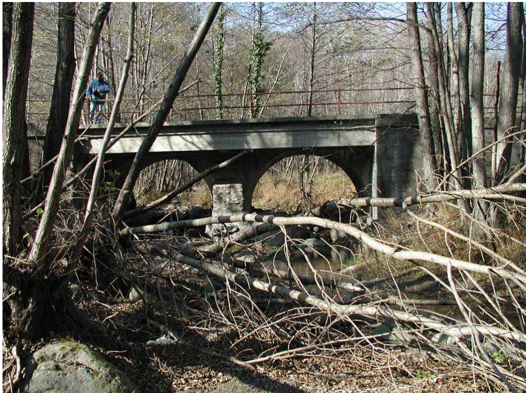
Foto 002 – Opera BATTPO002 . Da valle, sponda sinistra del rio affluente del T. Chisone.
