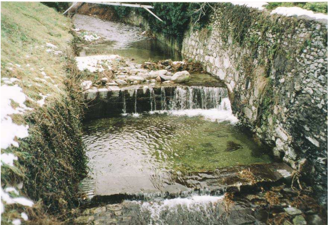
Foto 006 – Opere BATTSO007 e BATTSO008 . Ripresa da valle, in corrispondenza dell'attraversamento BATTAG010 sul Rio Comba Ciampiano.
