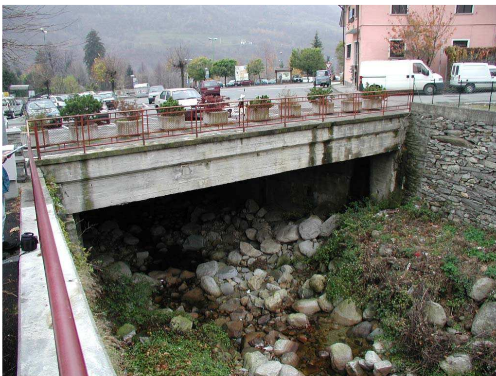
Foto 006 – Opera BATTPO006 . Da monte, sponda sinistra del Rio Comba Ciampiano.
