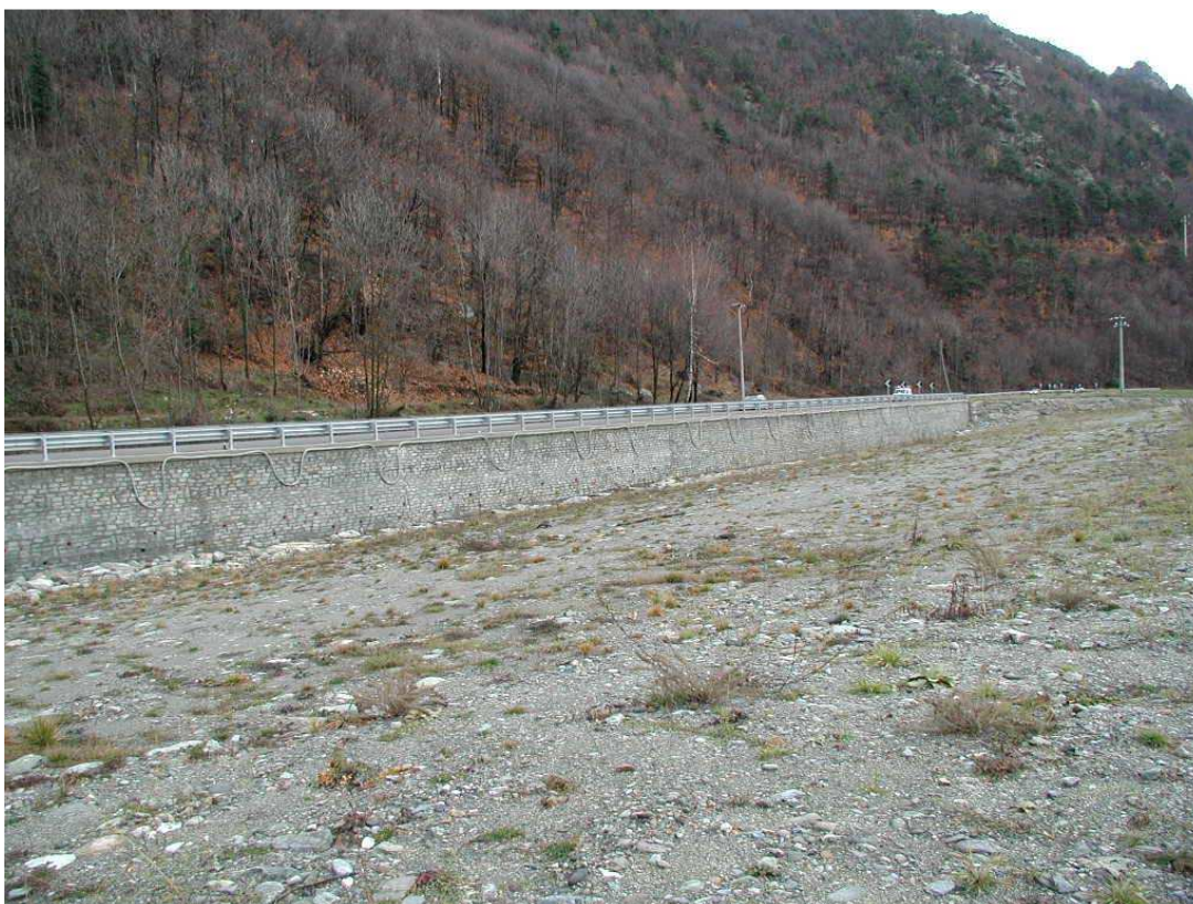
Foto 032 – Opera BATTDS036 . Ripresa da monte, sponda sinistra del T. Chisone.
