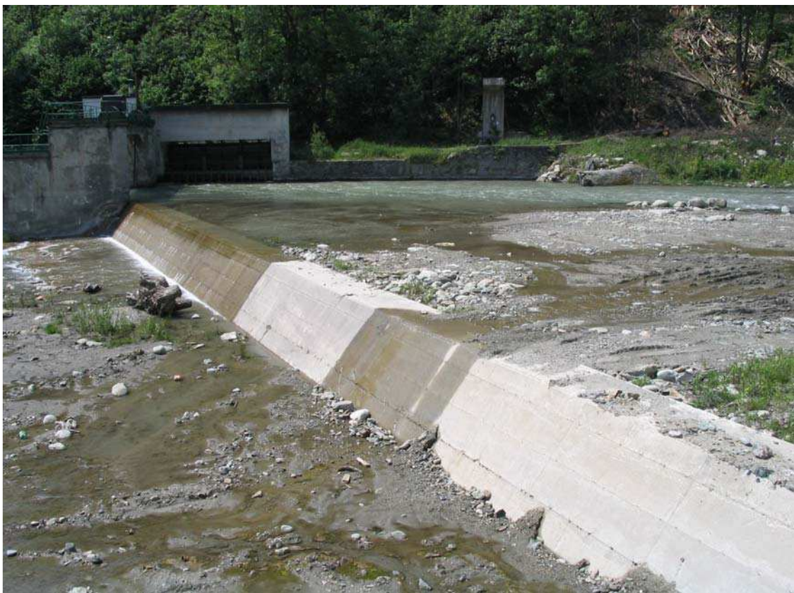
Foto 007 – Opere BATTSO009 . Ripresa da valle, sponda sinistra del T. Chisone
