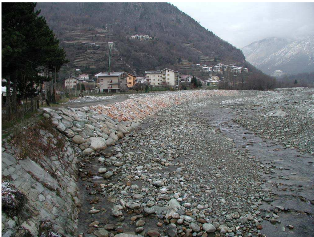
Foto 011 – Opera BELTDS011 . Da valle, in corrispondenza del ponte BELTPO013 , sul T. Chisone.
