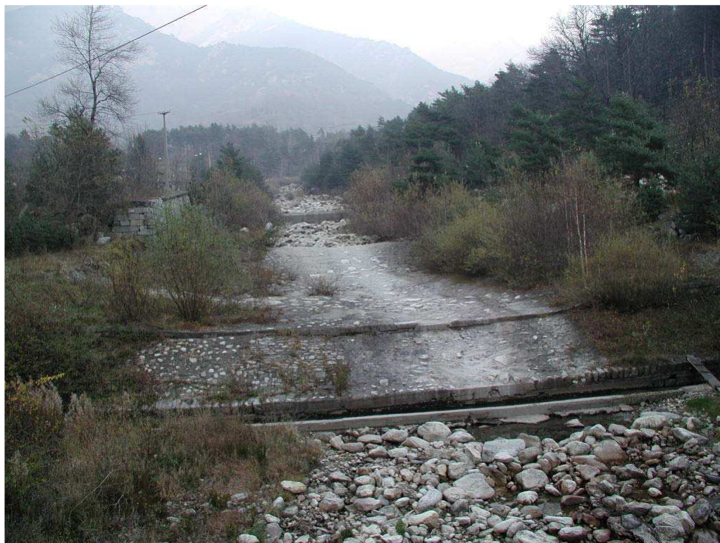
Foto 001 – Opere BATTBR001 , BELTBR002 e BATTBR003 . Riprese da valle, in corrispondenza del ponte BELTPO005 .
