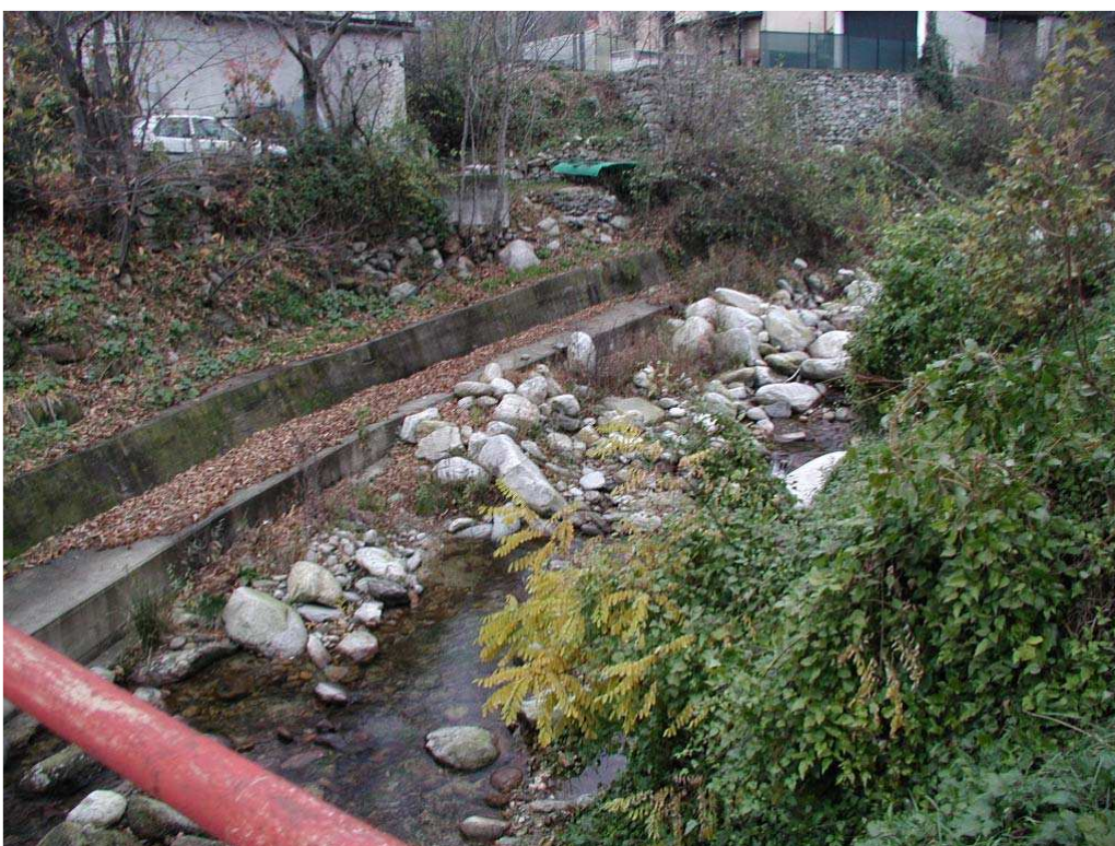
Foto 006 – Opera BATTDS006 . Da valle, in corrispondenza del ponte BATTPO008 , sul Rio Comba Ciampiano.
