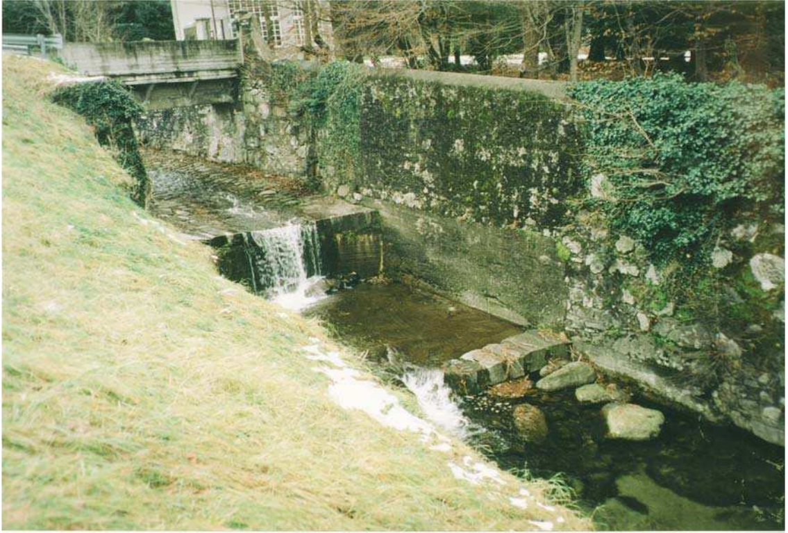
Foto 005 – Opere BATTSO005 e BATTSO006 . Ripresa da valle, sponda destra del Rio Comba Ciampiano.
