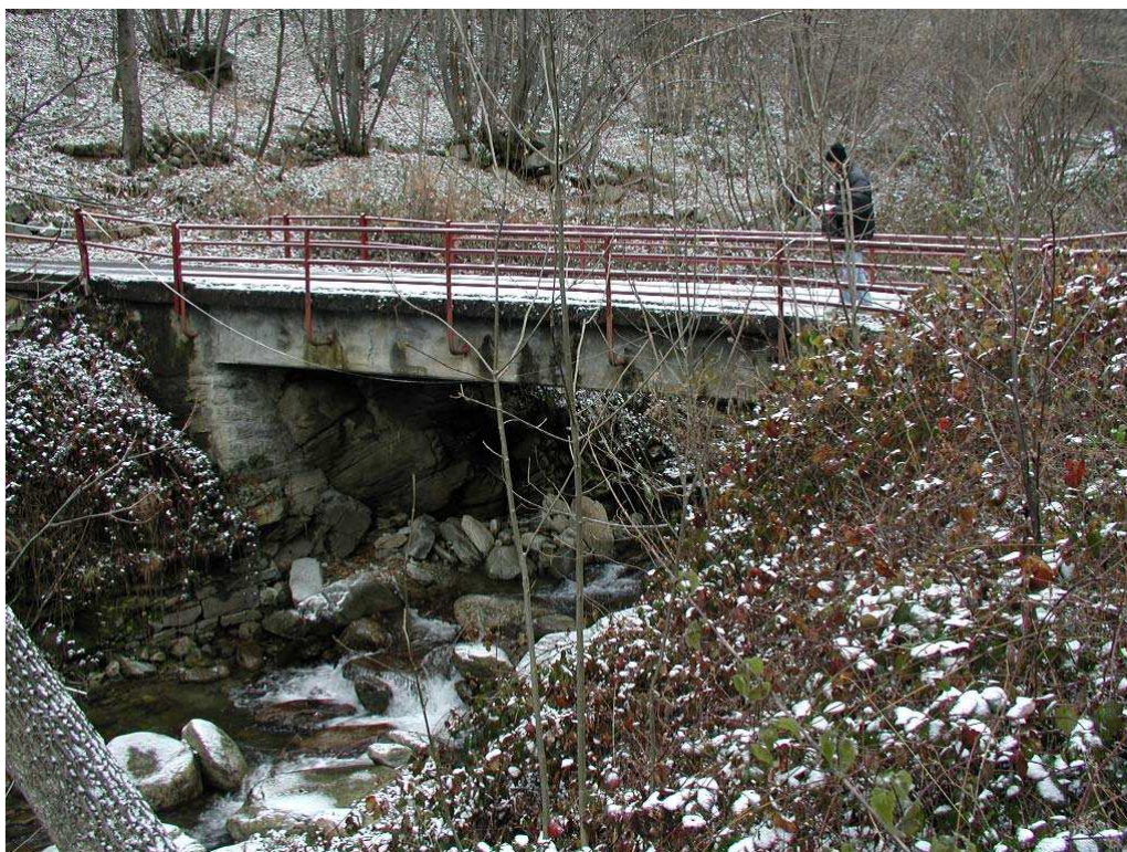
Foto 012 – Opera BATTPO012 . Da monte, sponda destra del Rio Comba Ciampiano.
