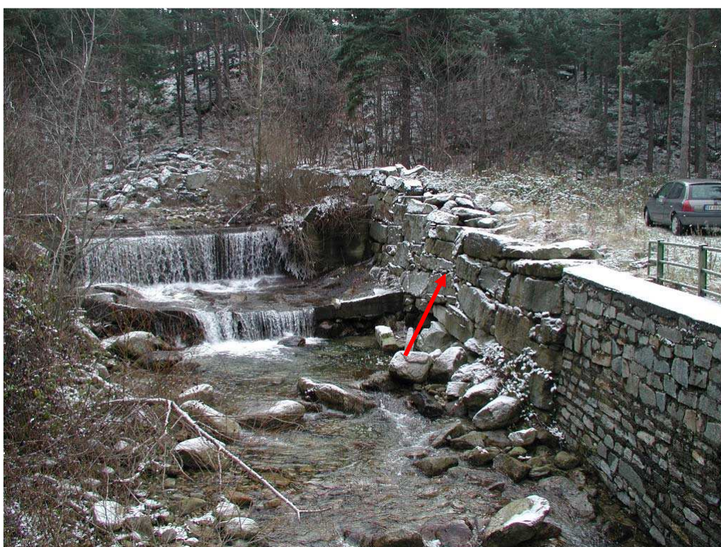
Foto 008 – Opera BATTDS008 . Ripresa da valle, in corrispondenza del ponte BELTPO011.
