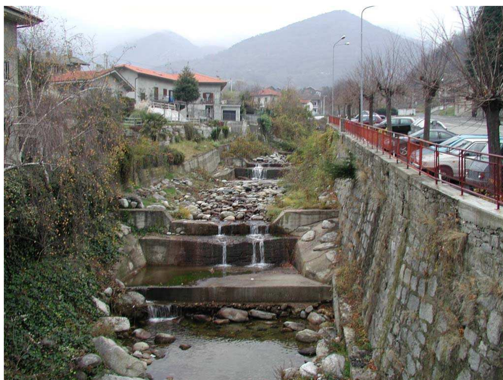
Foto 002 – Opere BELTBR004 e BATTBR005 . Da valle, dal ponte BATTPO006 .
