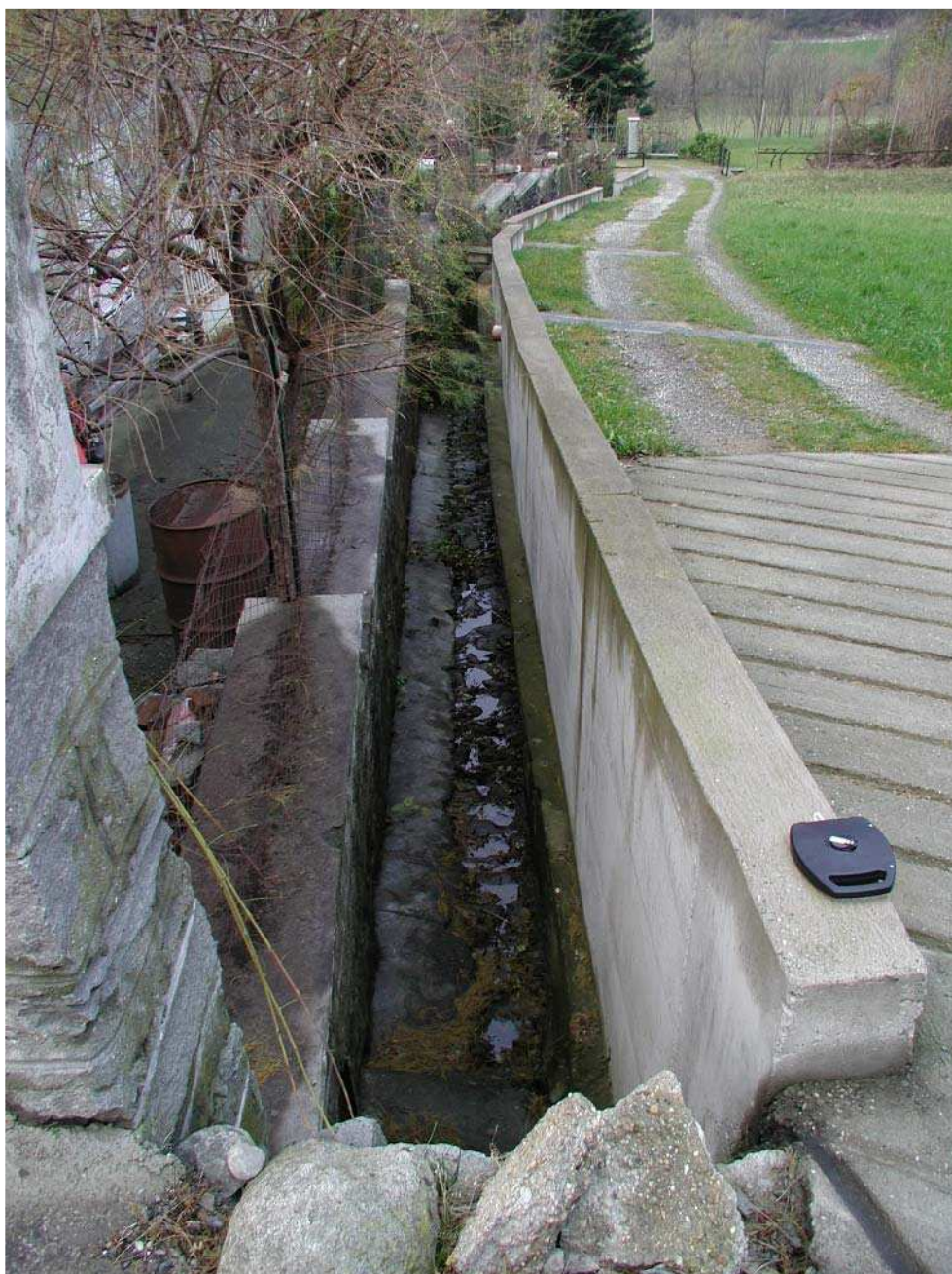
Foto 002 – Opera BATTCA002 . Da monte, in corrispondenza dell'opera.
