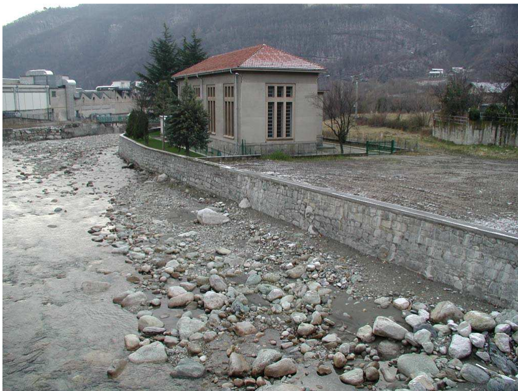
Foto 013 – Opera BELTDS013 . Ripresa da monte, in corrispondenza del ponte BELTPO013 sul T. Chisone.
