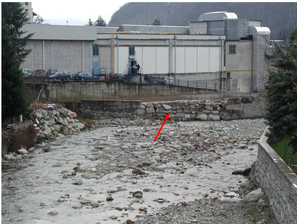
Foto 015 – Opera BELTDS015 . Da monte, in corrispondenza del ponte BELTPO013, sul T. Chisone.
