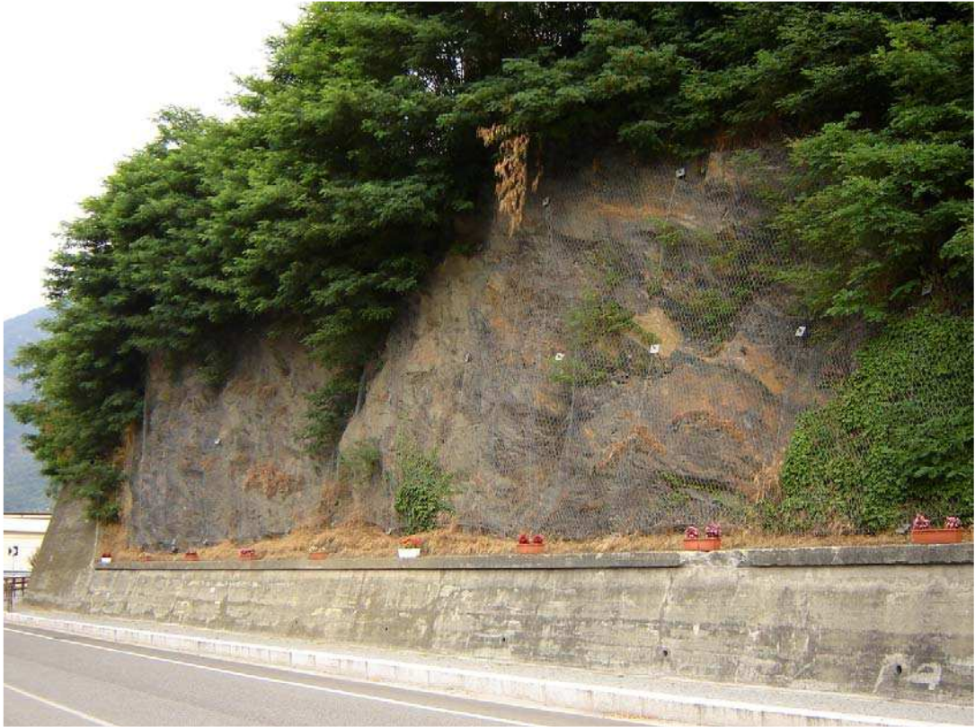
Foto 003 – Opera BATTPR003 (reti e cavi) – Ripresa dalla S.R. n. 23.
