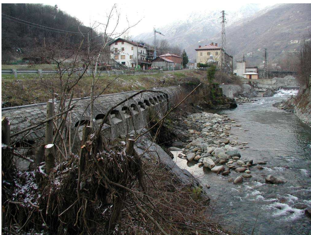
Foto 018 – Opera BATTDS018 . Da valle, in corrispondenza dell'opera.
