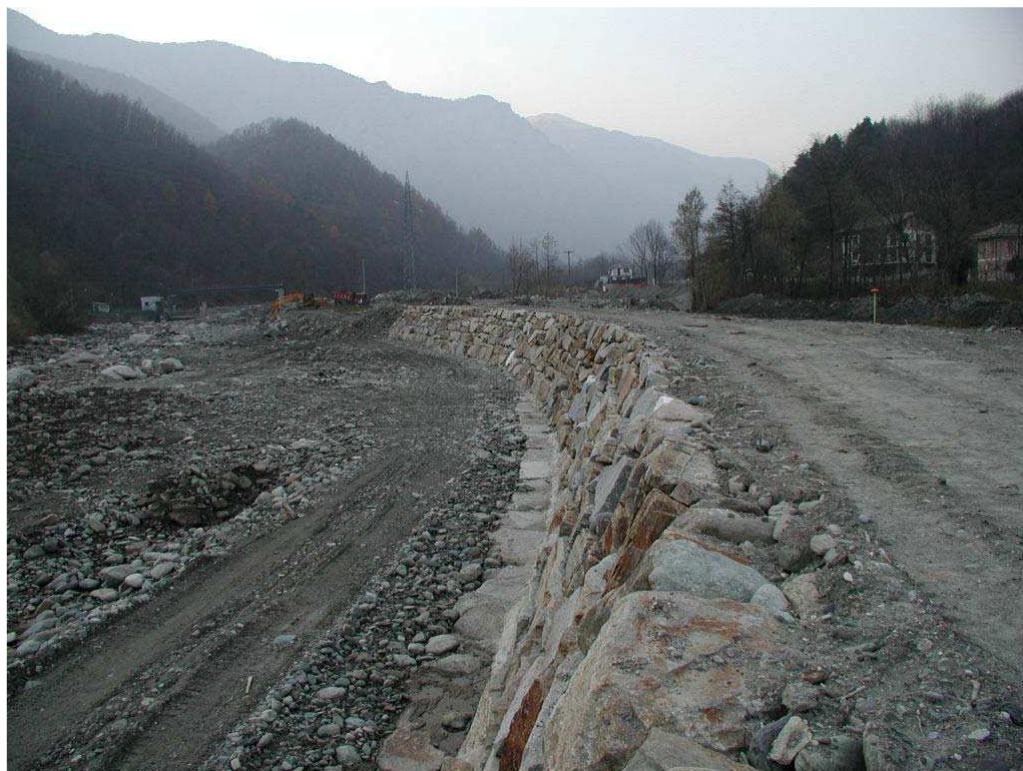
Foto 003 – Opera BELTDS003 . Da valle, in corrispondenza dell'opera (sponda sinistra del T. Chisone).
