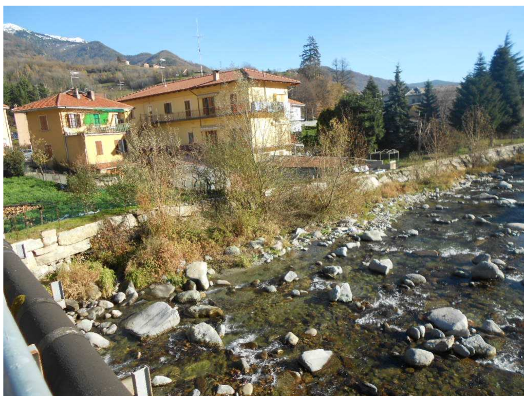
Foto 014 – Opera BATTD014 . Da monte, in corrispondenza del ponte BELTPO013.
