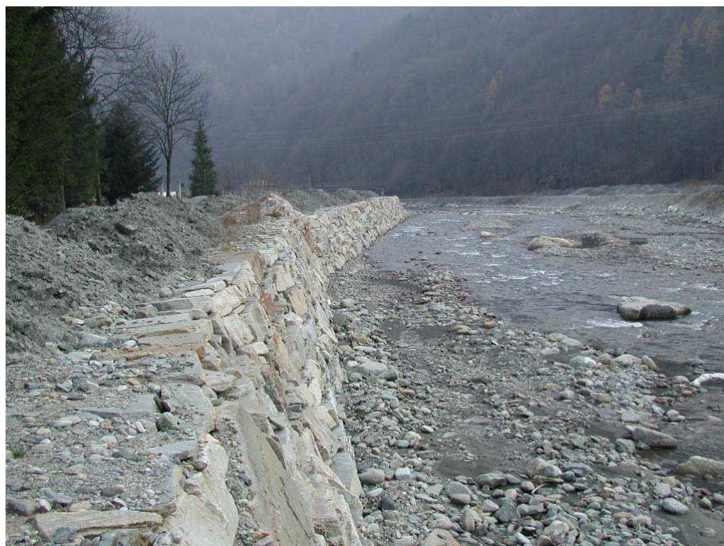
Foto 002 – BATTDS002. Da monte, in corrispondenza dell'opera (sponda sinistra del T. Chisone).
