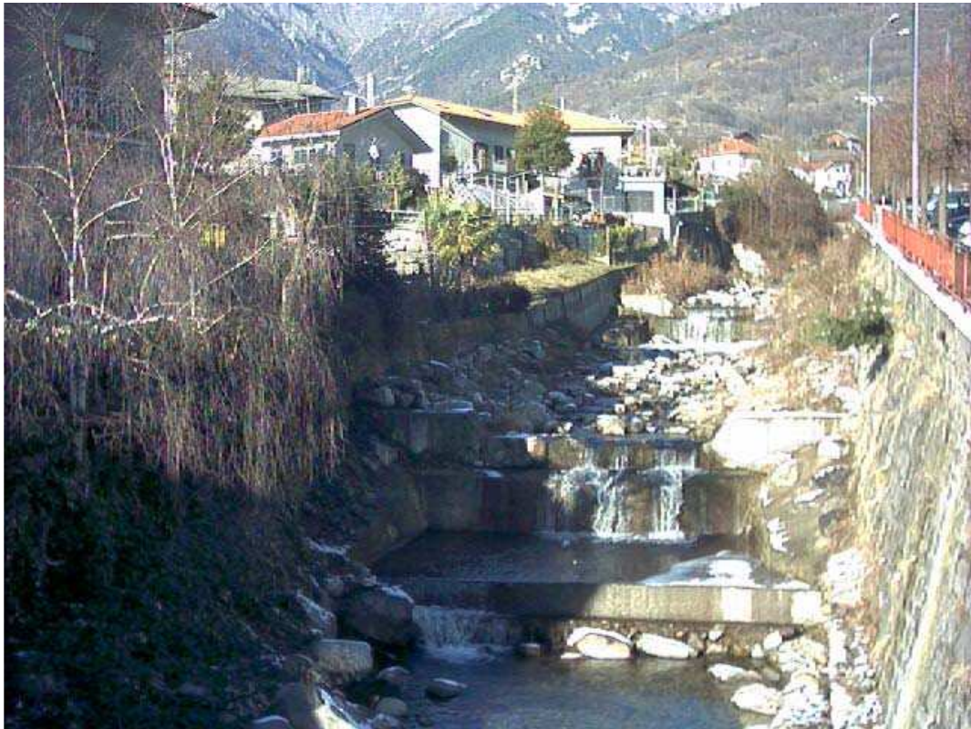
Foto 021 – Opera BELTDS021 . Ripresa da valle (dal ponte BATTPO006 ) del muro di sponda destra del Rio Comba Ciampiano.
