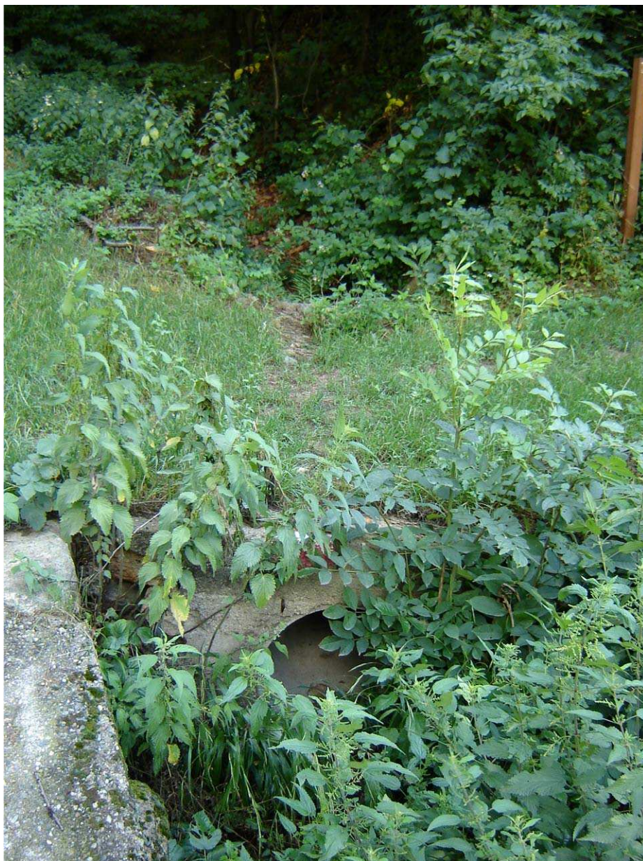
Foto 012 – Opera BATTAG012 . Da valle, sponda destra del Rio Meano.
