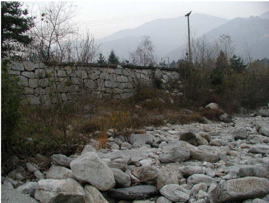
Foto 024 – Opera BELTDS028 . Ripresa da valle, entro l'alveo del Rio Agrevo.
