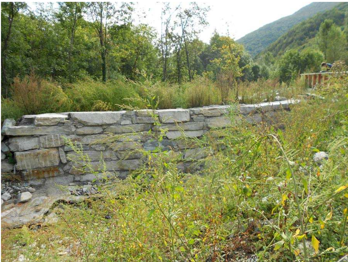
Foto 034 – Opera PAIRDS038 . Da valle, in corrispondenza dell'alveo del T. Garnier.
