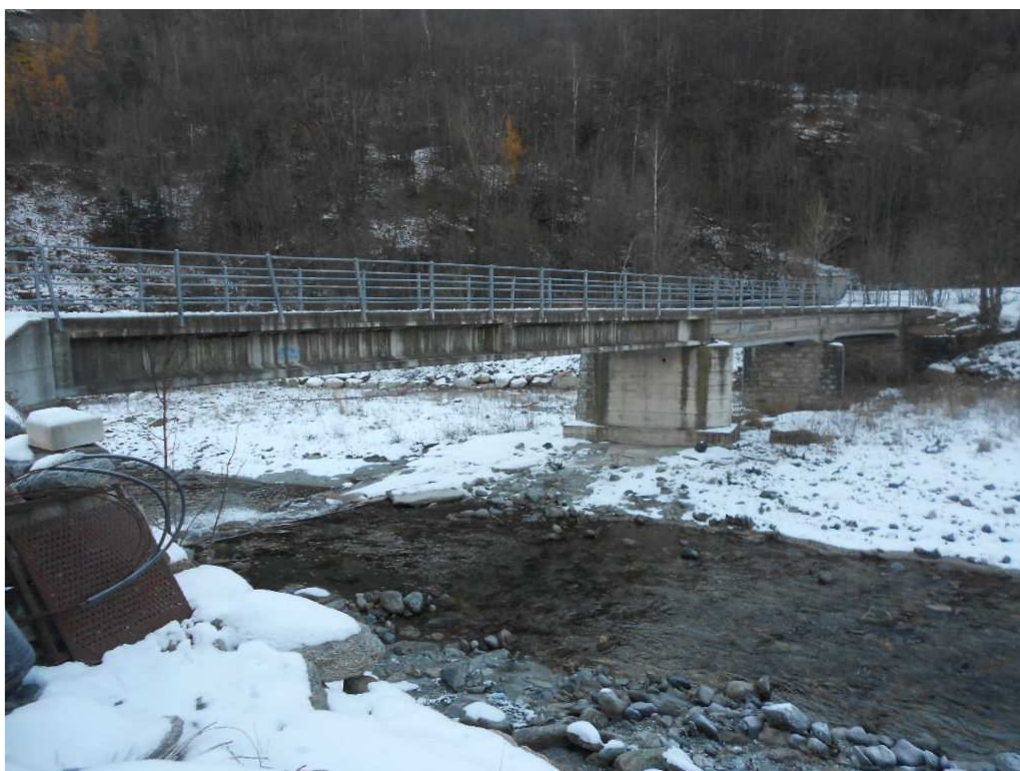
Foto 004 – Opera BATTPO004 . Da monte, sponda sinistra del T. Chisone. La luce del ponte appare ridotta rispetto alla larghezza dell'alveo.
