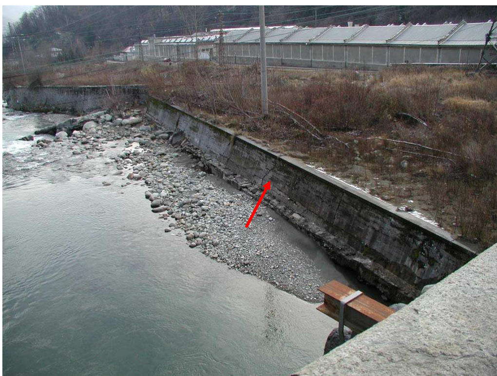
Foto 016 – Opera BATTDS016 . Ripresa da monte, in corrispondenza dell'opera.
