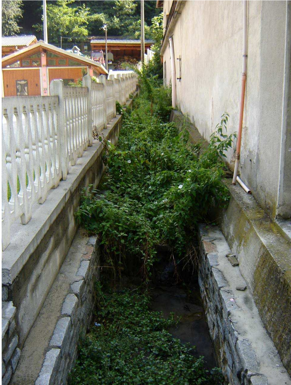
Foto 004 – Opera BATTCA004 – Ripresa da valle, dall'attraversamento BATTAG011 sul Rio di Poetti.
