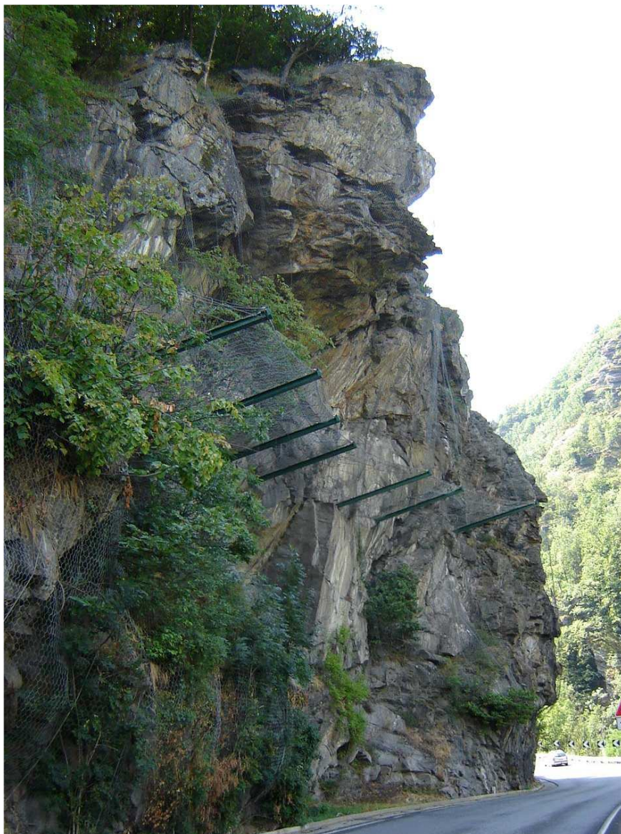
Foto 002 – Opera BATTPR002 (paramassi) – Ripresa da monte, dalla S.R. n. 23.
