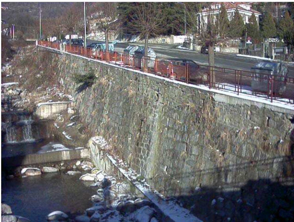
Foto 020 – Opera BATTDS020 . Ripresa da valle, del muro di sponda sinistra del Rio Comba Ciampiano.
