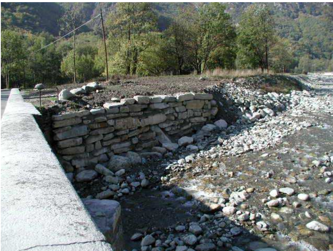
Foto 026 – Opera BATTDS030 . Ripresa da valle, dal ponte BELTPO001.
