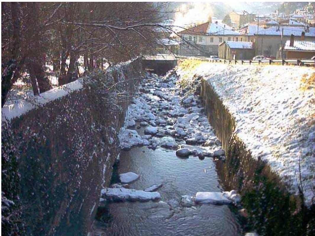
Foto 022 – Opere BATTDS023 (muro di sponda sinistra) e BELTDS024 (muro di sponda destra), riprese da monte.
